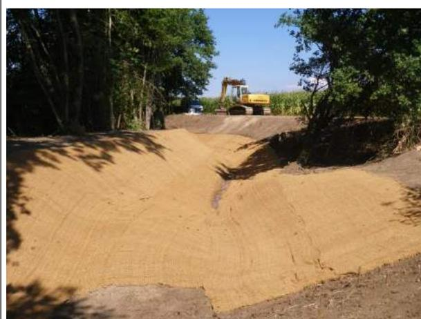
Création de la frayère avec installation d'un geotextile biodégradable pour éviter les départs de terre lors de la mise en eau
